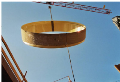
Bild 9: Ablassen des GFK-Rohres
