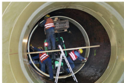
Bild 10: Montage des Bogenabschnittes
