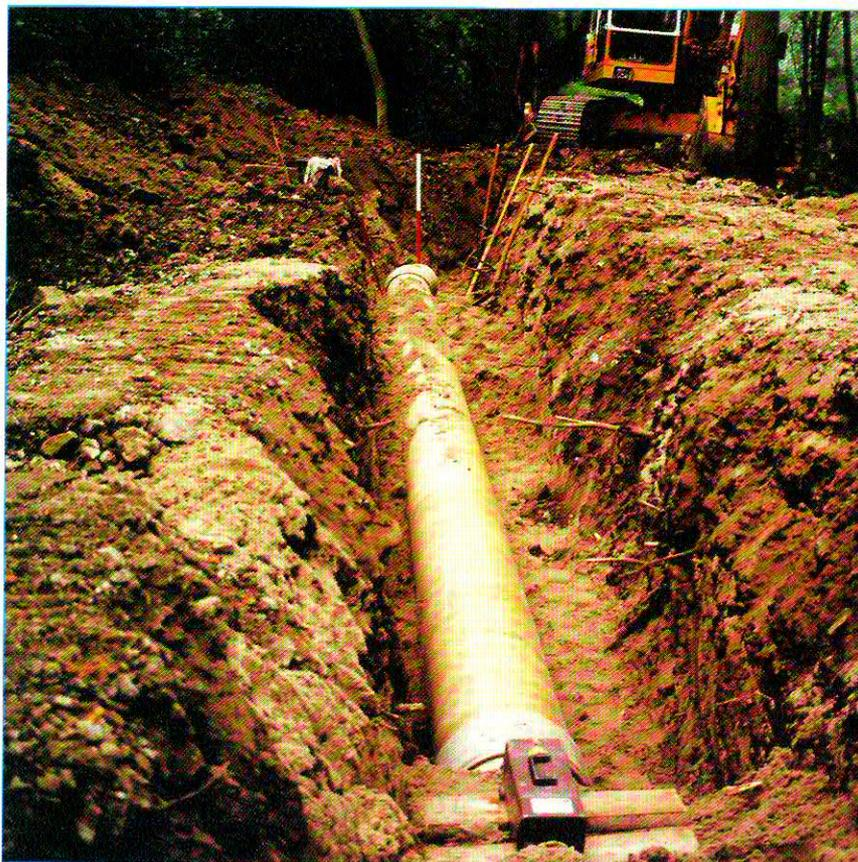
Verlegung der Druckrohrleitung unter Verwendung des anstehenden Bodens
