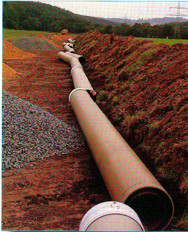
HOBAS-Doppelrohre für Trinkwasserschutzzonen
