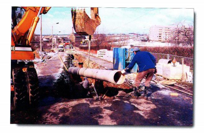
Anwendungsgebiet: Freispiegelleitung als Mischwasserkanal im öffentlichen Netz
