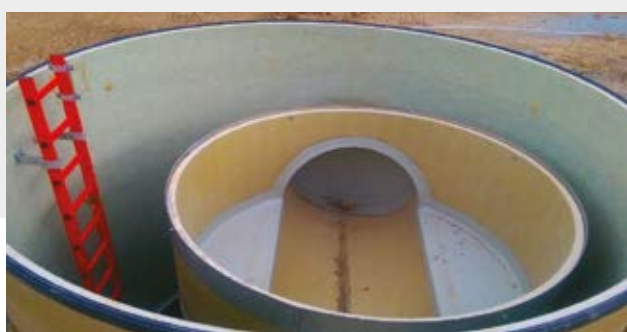
Pozo de descarga y aliviadero
