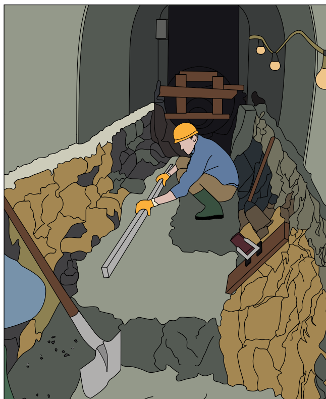
Fig. 17: Reprofilage du radier du collecteur existant en prévision de l'installation
